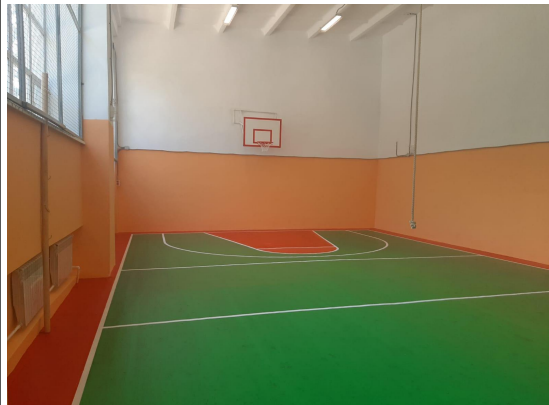
Спортзал и кровля, школа с.Виноградовка,
