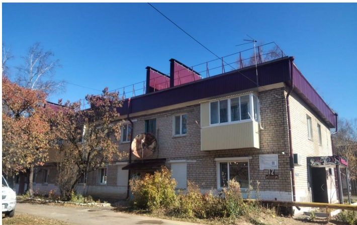
Капитальный ремонт кровли МКД ул. Банивура, д.12 с. Анучино
