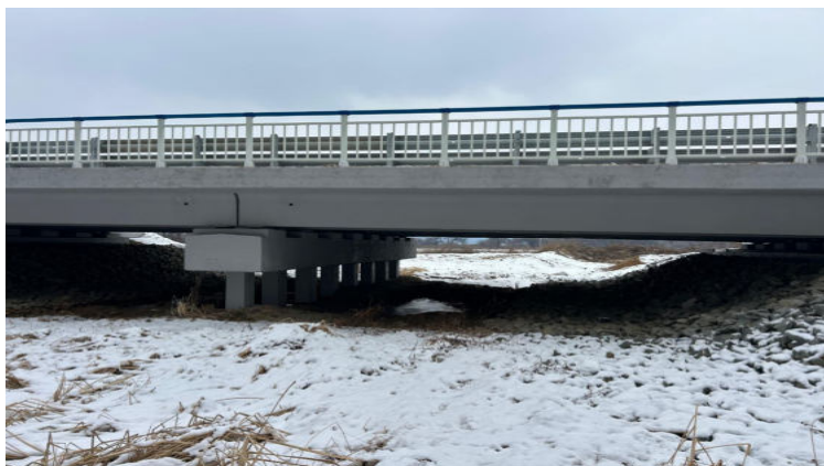
Искусственные сооружения (мосты км 98+186), 2025
