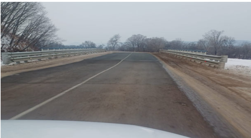
Искусственные сооружения (мосты км 84+872 ), 2025
